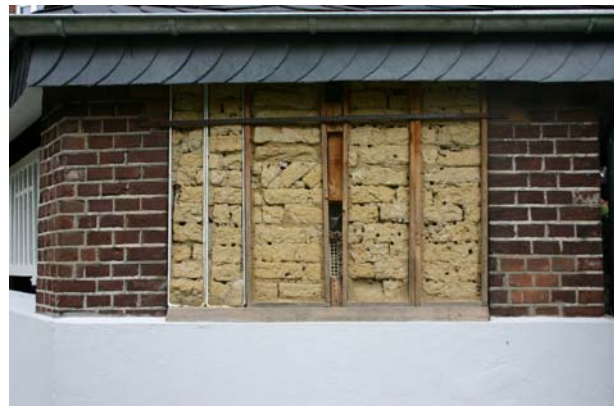
Abb. 2: Die Bretterrahmen mit passgenau gesägten Ziegelblöcken sind in einen Mauerdurchbruch des Gartenpavillons (am Naturschutzzentrum in Rees-Bienen) bündig eingefügt. (Foto: M. Brühne)
